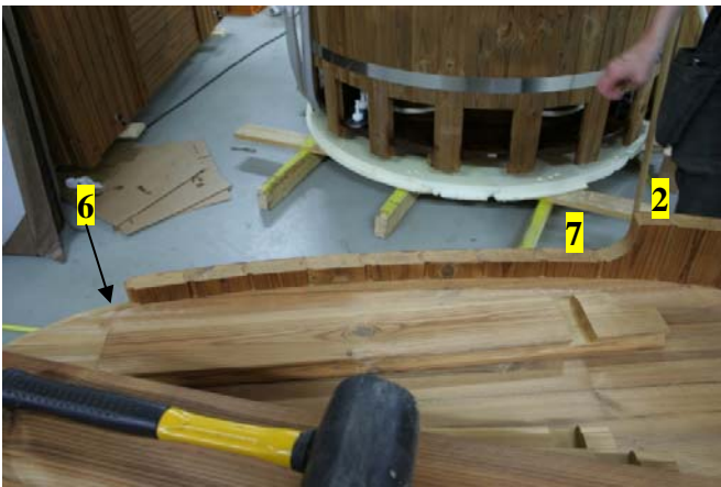
Kahdeksan sivulaudan jälkeen ryhmästä 7 kiinnitä sitten sivulauta no. 6.
