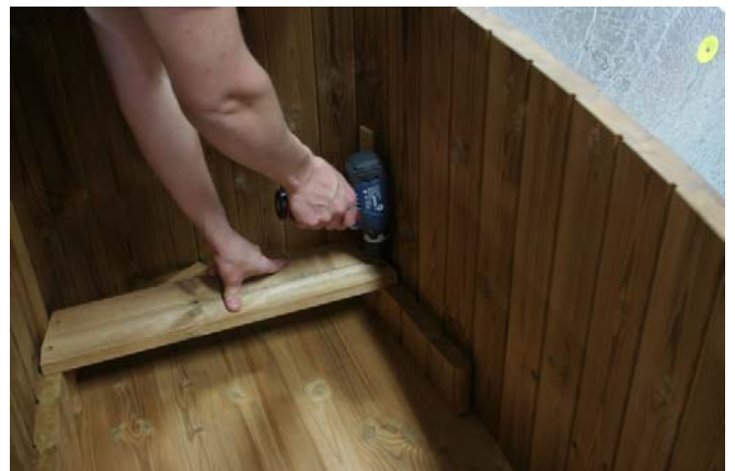
Esiporaa 3 mm poralla ja ruuvaa kinni istuinosa neljällä ruuvilla, älä unohda käyttää mukana olevia ”prikkoja”!
