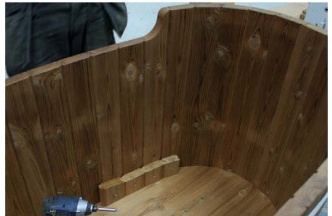
Ruuvaa kuvan mukaisesti kiinni kaikki palat. HUOM! Ensimmäinen ja viimeinen pala ovat erilaisia, katso kuva. Tee samalla tavalla toisella puolella
