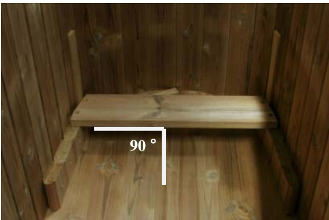
Sijoita nyt ensimmäinen istuinosa, mukaan tulevat ”kalibrointipalat auttavat asettamaan istumen oikein. Tarkista että istuinosa on 90-asteen kulmassa pohjan kanssa.
