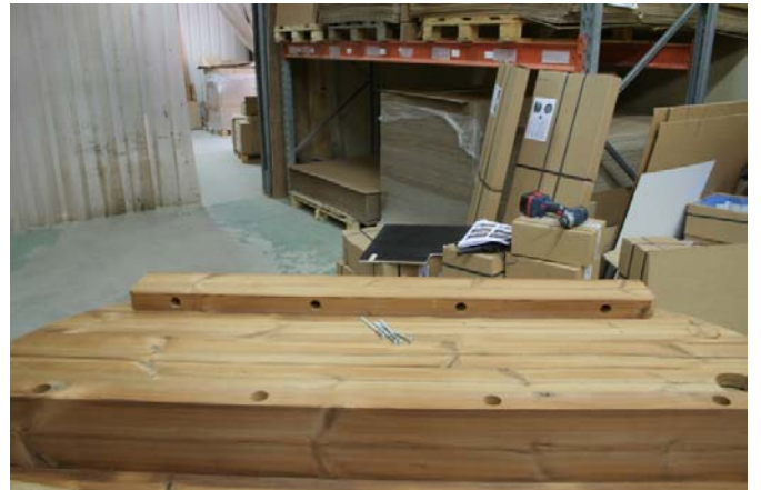
Asenna ensimmäiseksi tukijalat pohjan alapuolelle, tukijaloissa on ruuveille poratut reiät.
