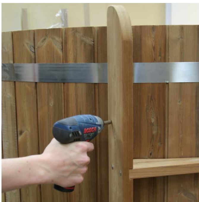
Ruuvaa kiinni ulkopuolinen tikapuu kolmella ruuvilla per sivu.
