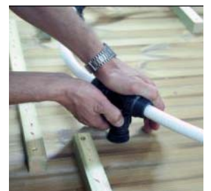
T-kappaleet painetaan ja ruuvataan kiinni
