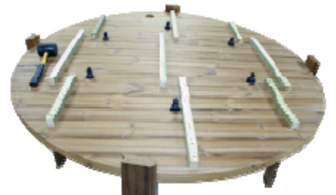
T-kappaleet painetaan ja ruuvataan kiinni
