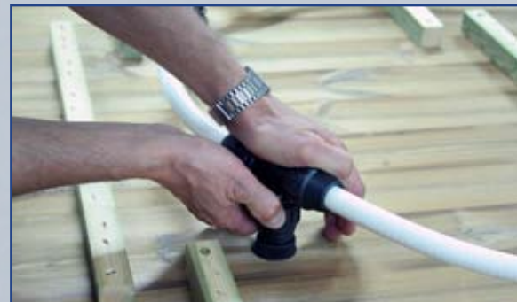
T-kappaleet painetaan ja ruuvataan kiinni ilmaventtiileihin
