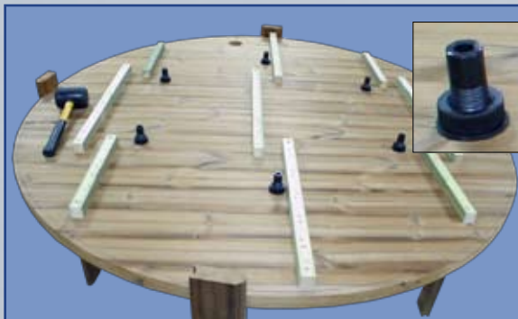
Ilmaventtiilit ruuvataan kiinni pohjaan
